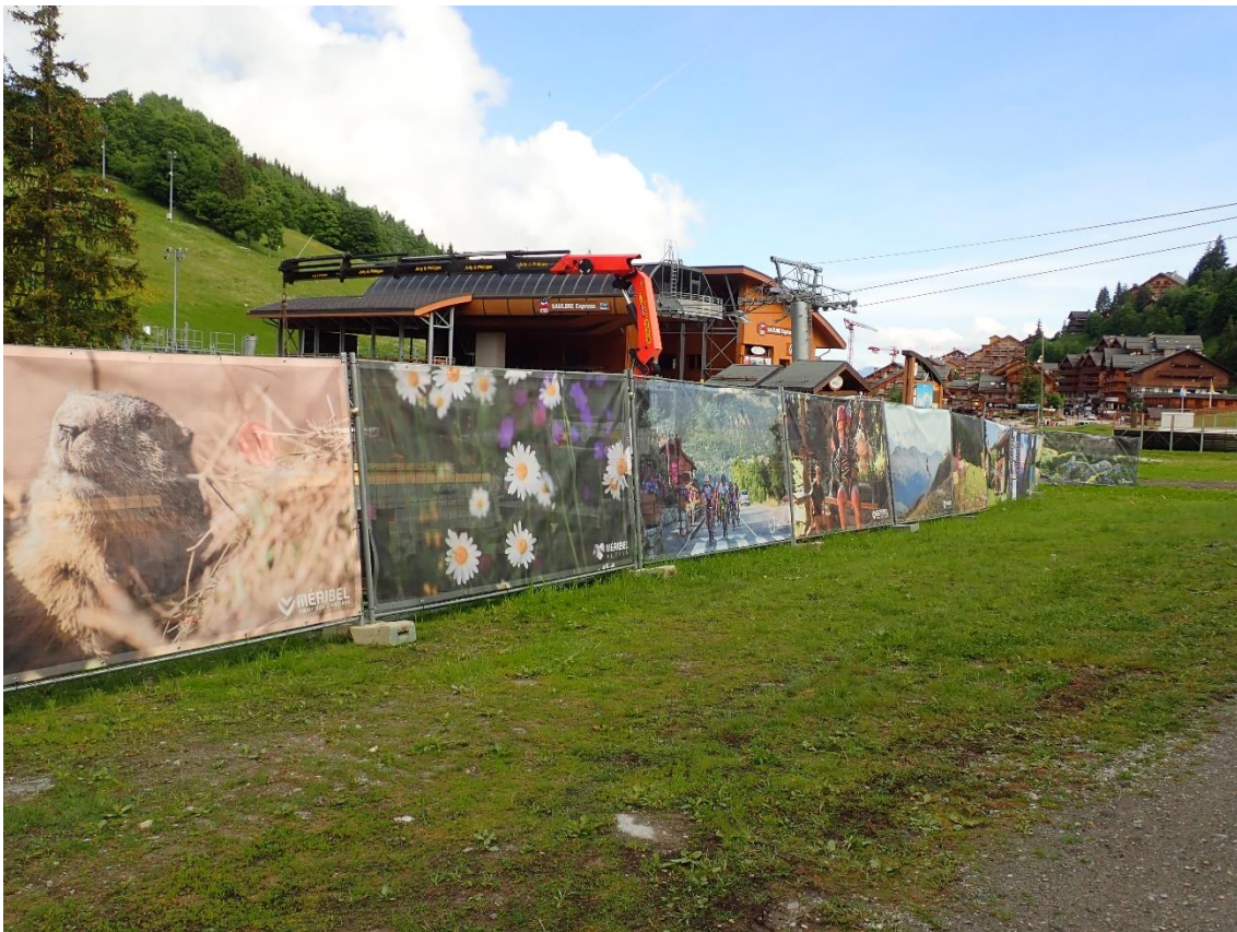
Exemples de clôture bâchée de zones de travaux situées à proximité de zones habitées
