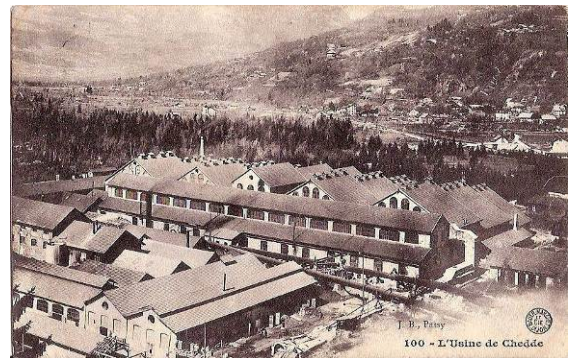
Usine de Chedde, évolution des bâtiments
