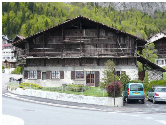
Maison passerande représentative du type ; Plateau d'Assy. Un rez de chaussée maçonné (les ouvertures ont été agrandies vers 1960), étage et comble en bois, toit à deux pans débordant largement .
