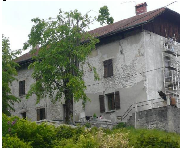
Maison forte de Lucinges à l'entrée de Passy. Travaux en cours
