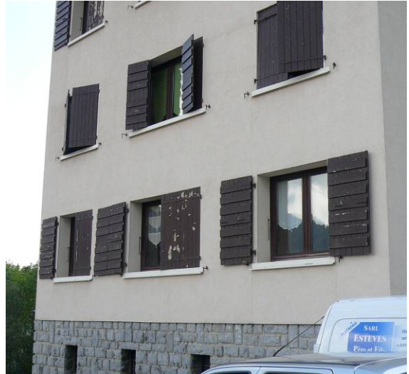
Isolation par l'extérieur, bavettes métalliques à la place des appuis. Plateau d'Assy
