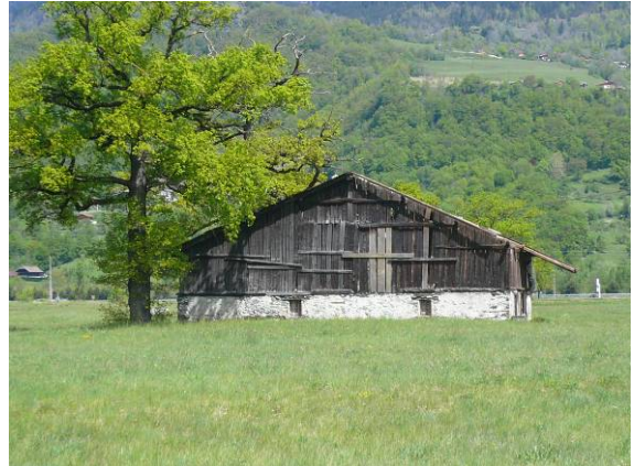
Un socle maçonné avec peu d'ouvertures, au dessus la grange avec structure et mantelage en bois, sans ouvertures.
