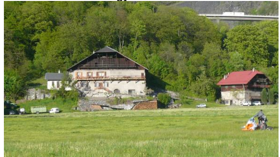
La tour de la Frasse est englobée dans cette grosse bâtisse, Chedde
