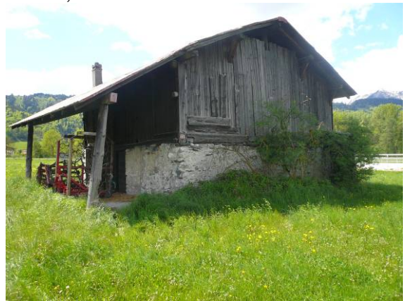
Un socle maçonné avec peu d'ouvertures, au dessus la grange avec structure et mantelage en bois, sans ouvertures.
