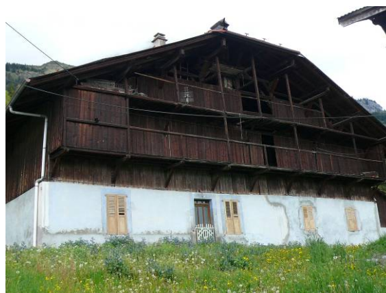
Maison passerande Cran. Rez de chaussée maçonné (les ouvertures ont été agrandies vers 1930), étage et comble en bois, toit à deux pans avec fausse croupe dite « Allemande ».
