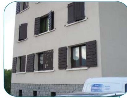
*Appauvrissement de la façade dû à l'isolation par l'extérieur: décrochement, bavettes métalliques remplaçant les appuis de fenêtres.*
