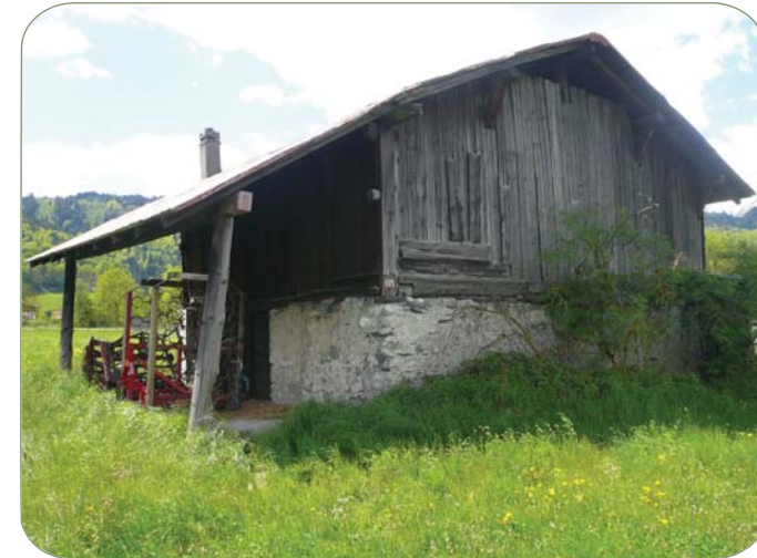
Un toit à deux pans, un socle maçonné avec peu d'ouvertures, au dessus la grange avec structure et mantelage en bois, sans ouvertures.
