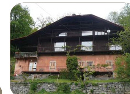
Grandes ouvertures (châssis fixes sans partition, sans occultations, cadres réduits de même teinte que le bardage), La Combe
