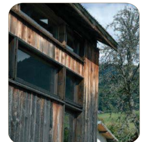
Ouvertures contemporaines dans une ancienne ferme. Cote d'Arbroz 74. Photo Nunc Architectes
