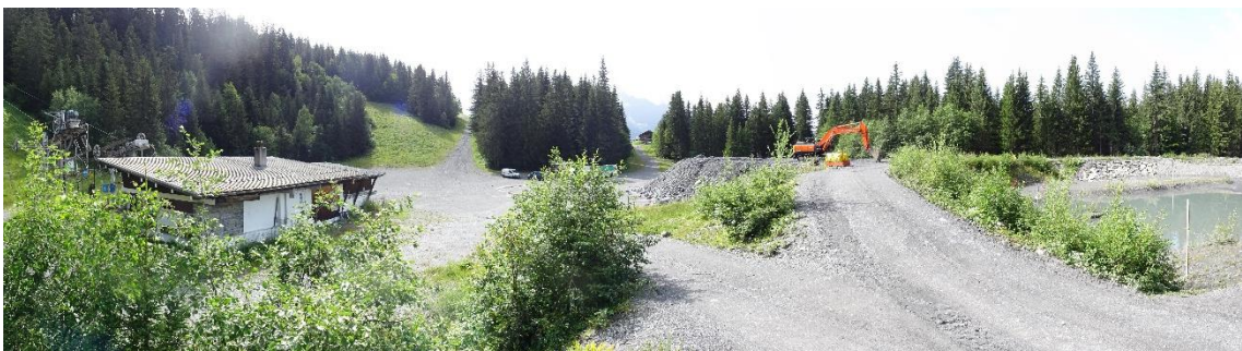
Ambiance 1 à l'aval : ambiance technique « d'arrière-cour » avec des bassins techniques, du bâti ancien, des dépôts sauvages. Le site est isolé du plateau de Plaine Joux par les boisements
