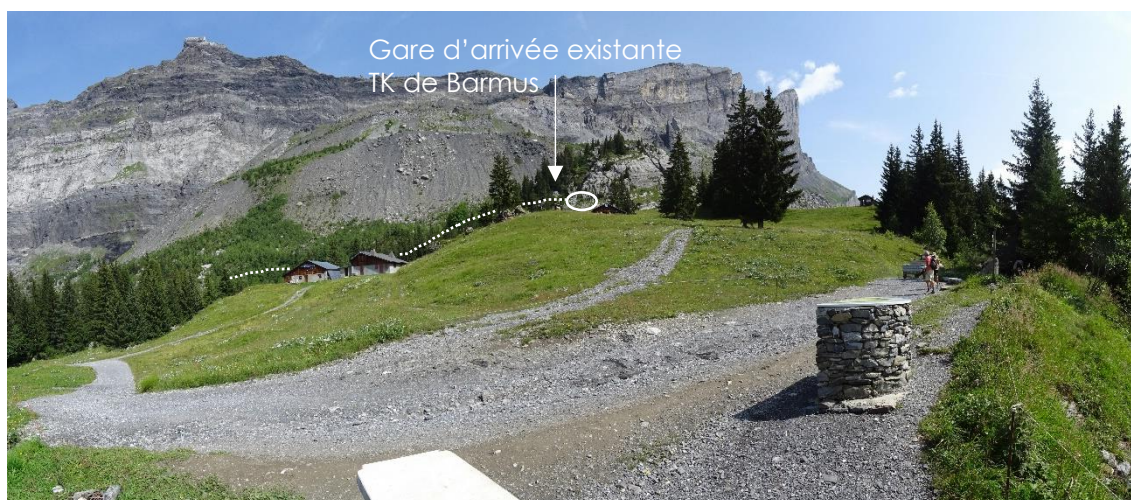
Vue depuis la piste d'accès depuis le belvédère. Le projet s'inscrit à proximité de la gare d'arrivée existante du téléski de Barmus.
