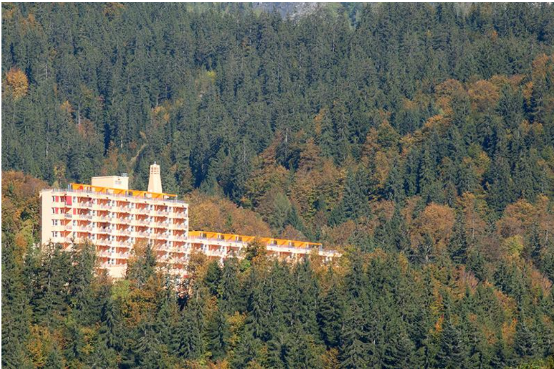
Figure 2 – Le sanatorium Martel de Janville transformé en logement - Source : CAUE 74 © Photos : Romain Blanchi
