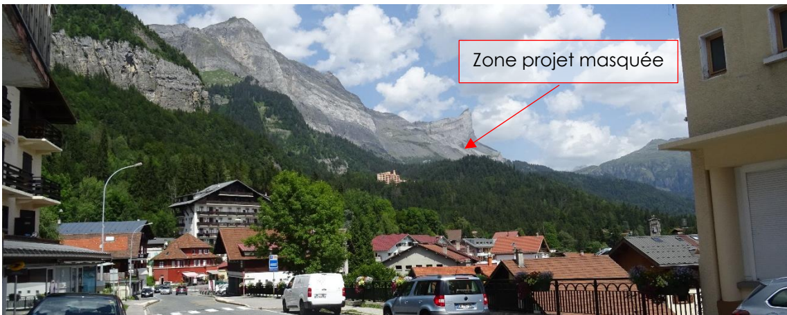
Figure 3 – Ancien sanatorium Martel de Janville et clocher de l'Eglise Notre-Dame-de-Toute-Grâce - plateau d'Assy. Absence de covisibilité avec le site projet depuis les espaces fréquentés (ici depuis le Plateau d'Assy)
