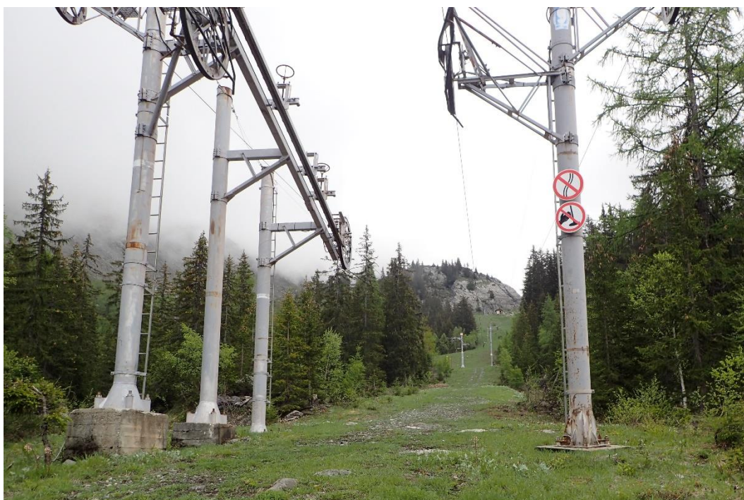
Massifs béton à arraser au départ de la ligne de téléskis
