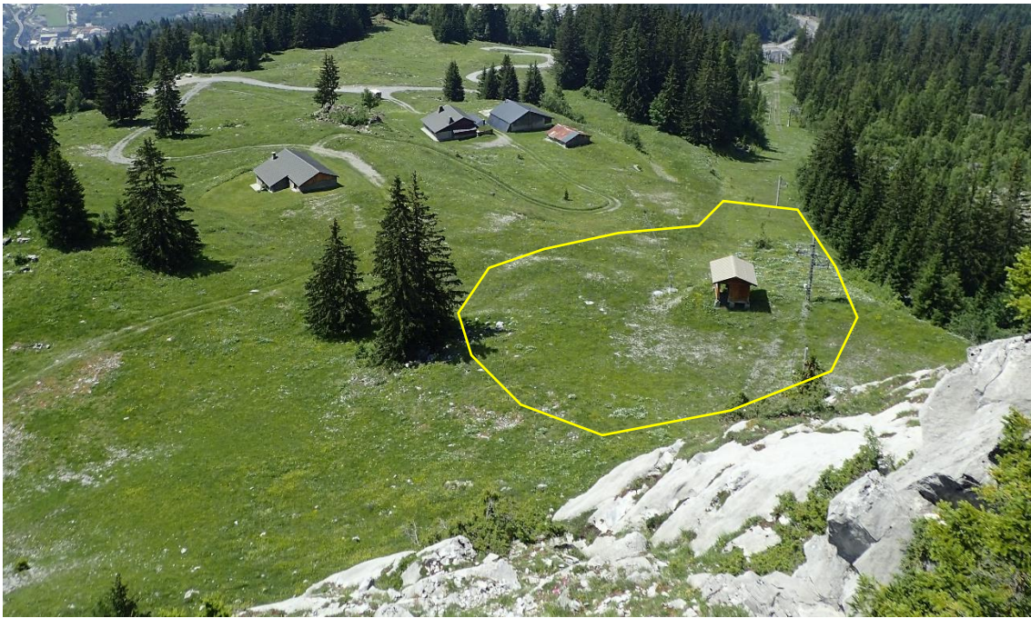
Vue générale de la zone de terrassement en G2
