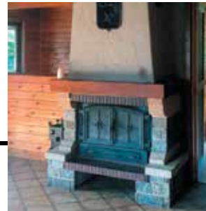
Foyer fermé avant et après travaux.
