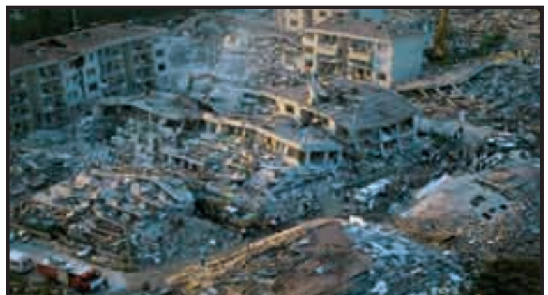
La ville de Gölcük (épicentre du séisme, intensité X) après le séisme de magnitude 7,9 qui a frappé la région d'Izmit (Turquie), le 17 août 1999. Ce séisme a provoqué la mort d'au moins 15 500 personnes, et l'effondrement partiel ou total de 50 000 immeubles (cliché : Yann Arthus-Bertrand)
