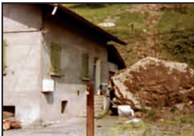
Rocher éboulé de la falaise de la Motte et parvenu jusqu'à une maison située rue des Touvières (1978)
