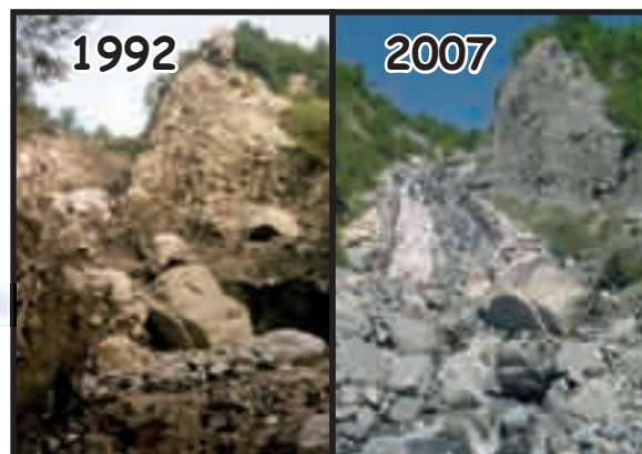
Le Nant Bordon au niveau de sa confluence avec l'Arve. En 1992, après une crue importante qui avait causé des dégâts sur la commune. En 2007, après la mise en place de seuils dans le lit du cours d'eau afin d'éviter les phénomènes de ravinement et de laves torrentielles
